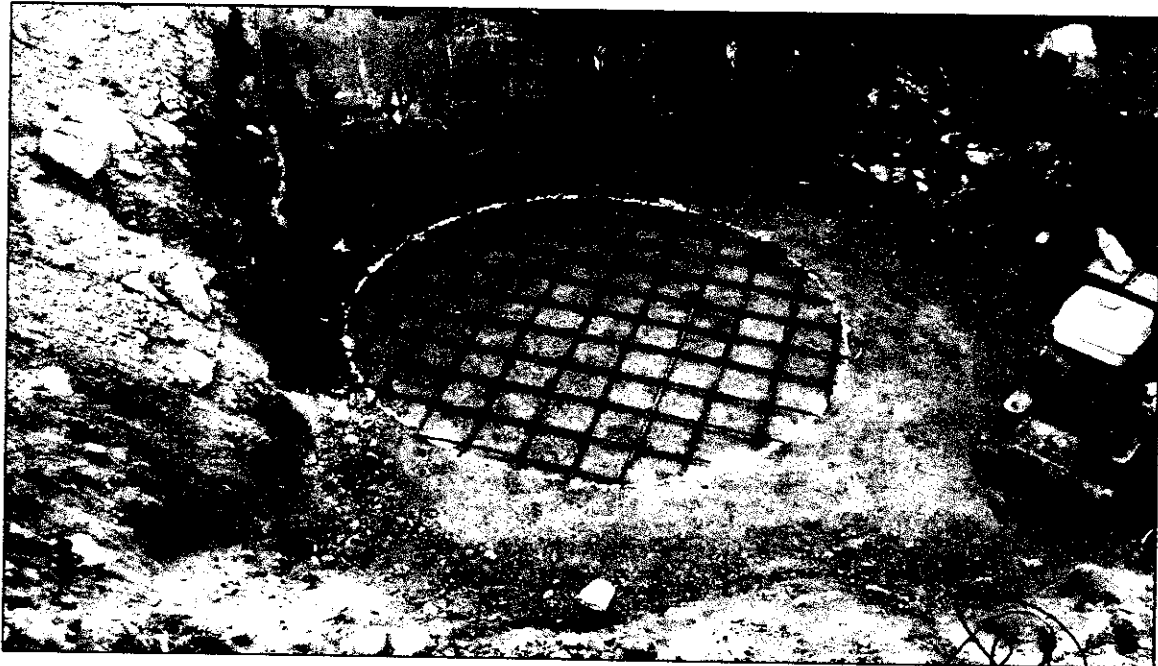
Ilustración 2: Suministro de acero en la base del tanque de 2,500. l.
