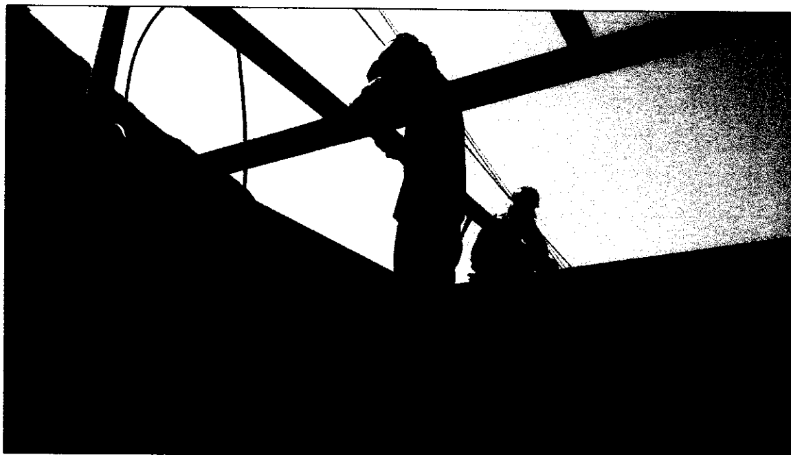
Ilustración 15: Instalación de vigas metálicas en techos.
